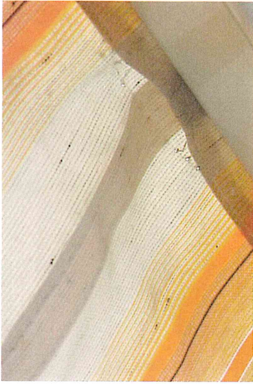
Bild 9.1.7 Möglicher Fadenniss im unteren Saum Ursache : Alterung des Nähfadens, Überlastung durch Wind, Regen, oder durch mangelnde Verarbeitung beim Nähvorgang
